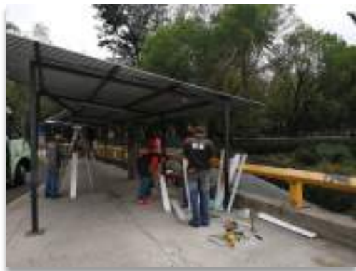
CETRAM CHAPULTEPEC Instalación de luminarias bajo cobertizo
