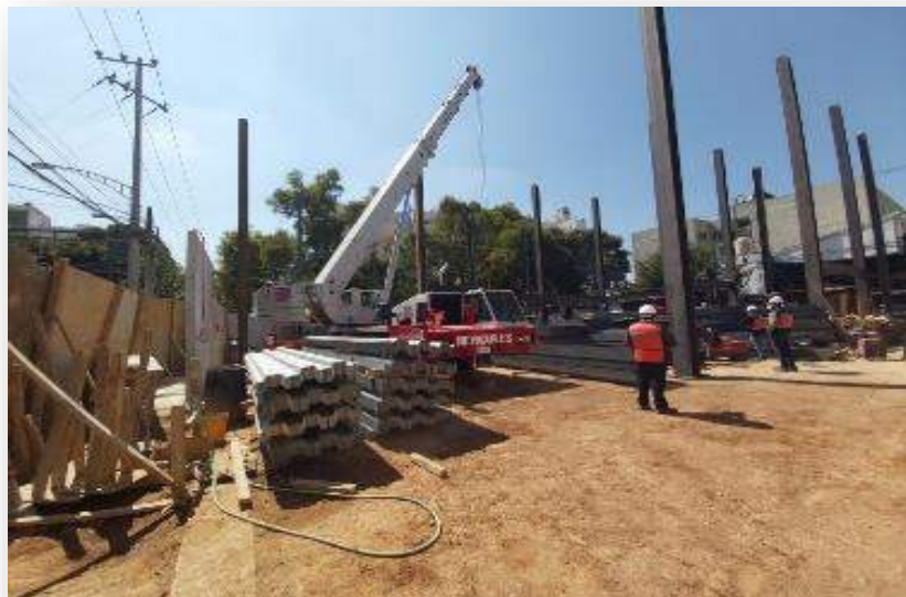
MONTAJE DE COLUMNAS DE ACERO
