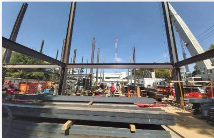
MONTAJE DE VIGAS DE ACERO
