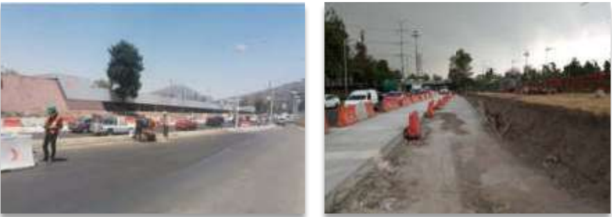
Fase 1: bajada gaza existente
