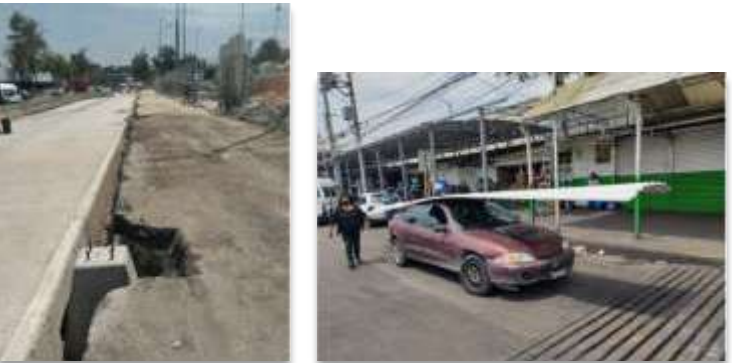
Fase 3: bcubierta de cablebús
