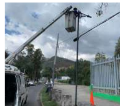
colocación de botones y cámaras de vigilancia
