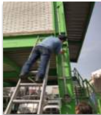
CETRAM TACUBAYA revisión de conexión eléctrica
