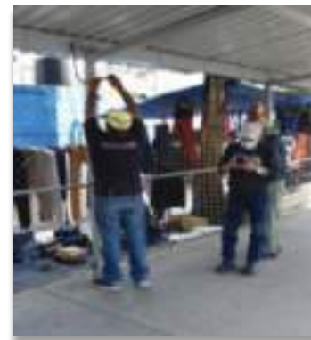
CETRAM MARTÍN CARRERA revisión de reflector y alimentación eléctrica en andenes
