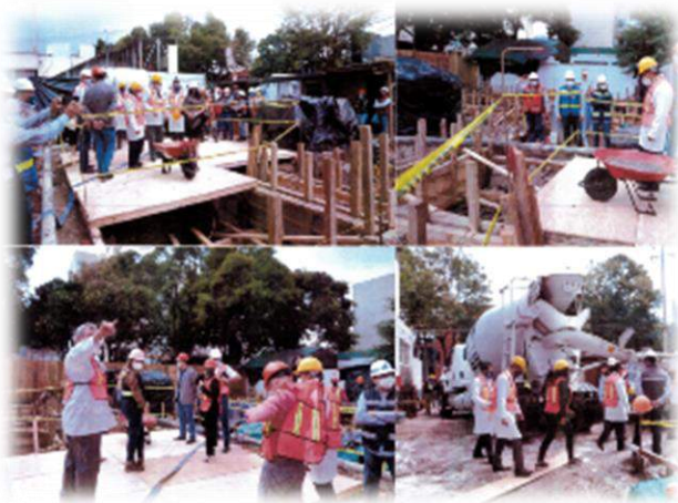
Trabajos para del primer colado
