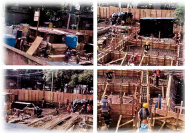
Avances en la construcción
