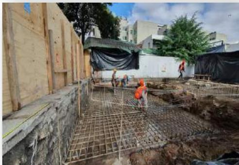
Armado de zapata de cimentación
